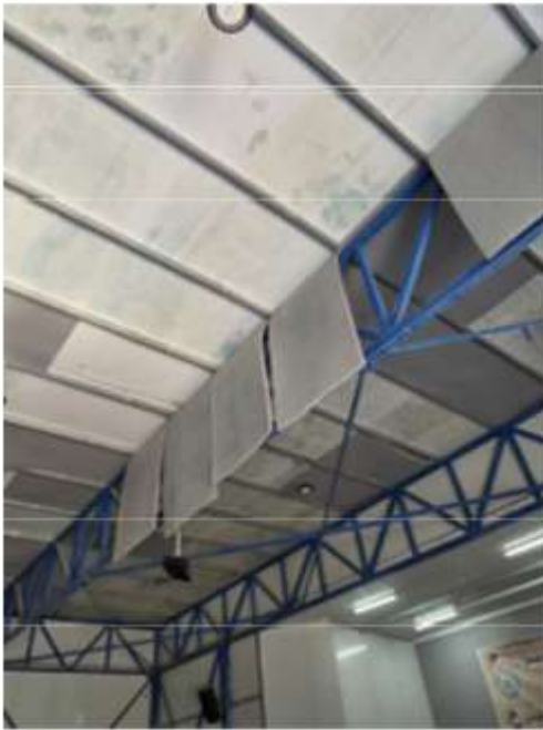
ألواح وصفائح عازلة للصوت مائلة للسقوط في القاعة الرياضية في مدرسة أبو قويدر الابتدائية
