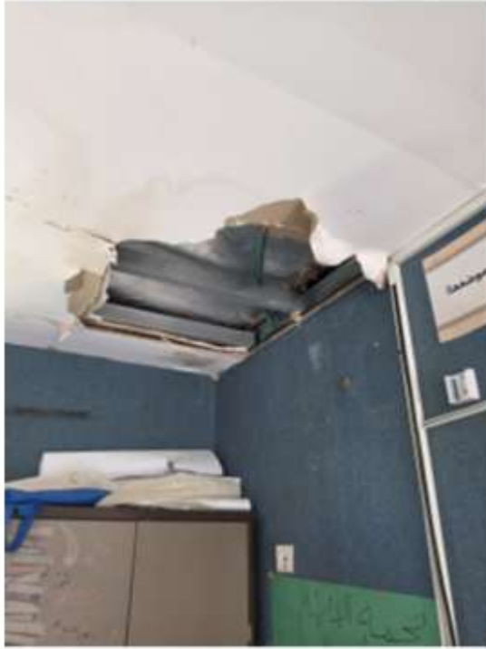
سقف في خطر انهيار في العازمة (ب)
