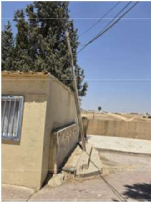
عمود اتصالات يواجه خطر انهيار فوري في العزازمة (أ)
