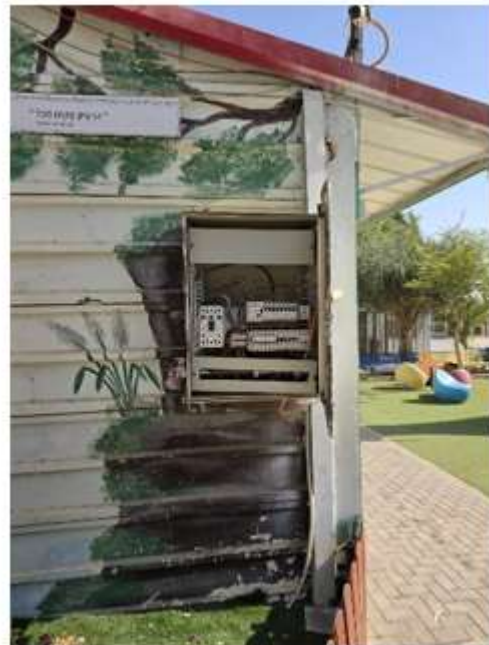
خزانة كهرباء مكشوفة، مدرسة أبو قويدر الابتدائية
